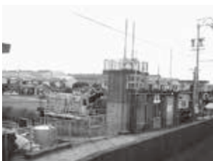
船倉ポンプ場
