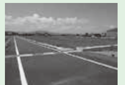
みなと小学校建設予定地 (8月1日現在)
